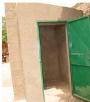
Une latrine VIP ou latrine améliorée à fosse auto-ventilée (LAA) comprend une (ou des) fosse(s) de réception et d'accumulation des boues dont les parois sont maçonnées, un ensemble de dalles en béton, une superstructure, une ou plusieurs cheminées de ventilation dont l'extrémité est munie d'un grillage anti-mouches et une toiture en tôle.
