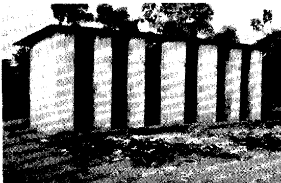
Dans beaucoup d'écoles, les latrines sont en mauvais état. (Togo)
