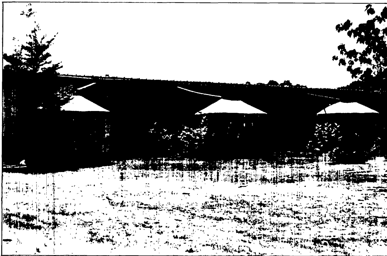
Citernes en ferrociment pour le captage d'eau de pluie — Ecole de Roumtenga - Burkina Faso
