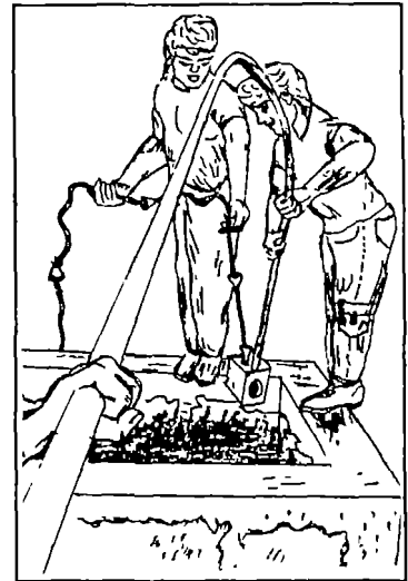
g1. Introducir la tubería
