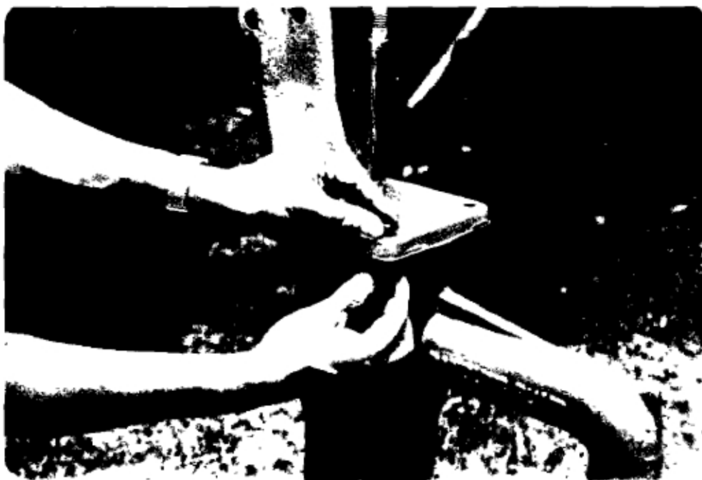
12. Mur dan baut dipasang antara badan pompa dan penutup.
