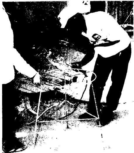
Soudure du support
