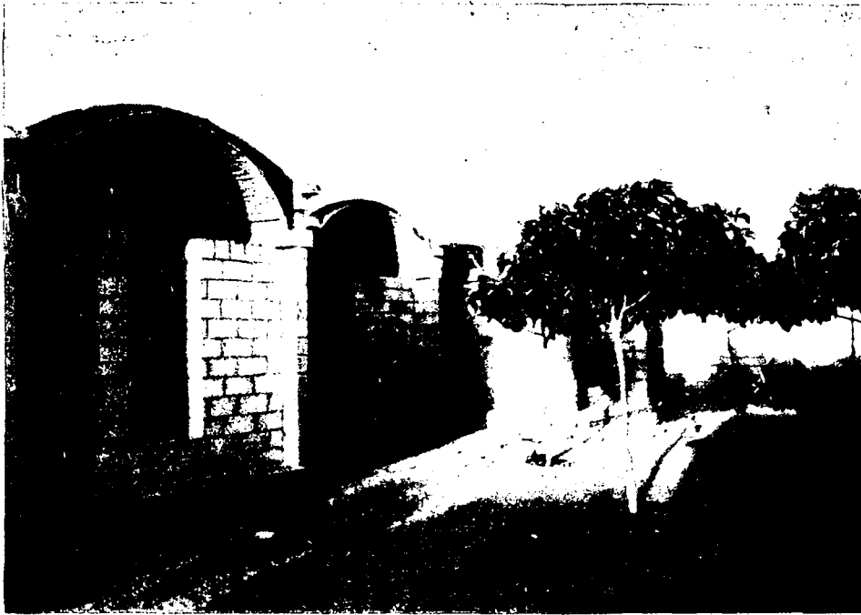
Photo 6 Façade des logements des étudiants qui donne sur la cour
