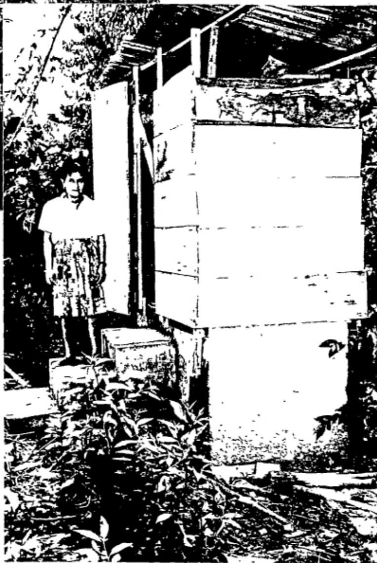
↑ Sanitario ecológico de doble cámara con caseta de material local
