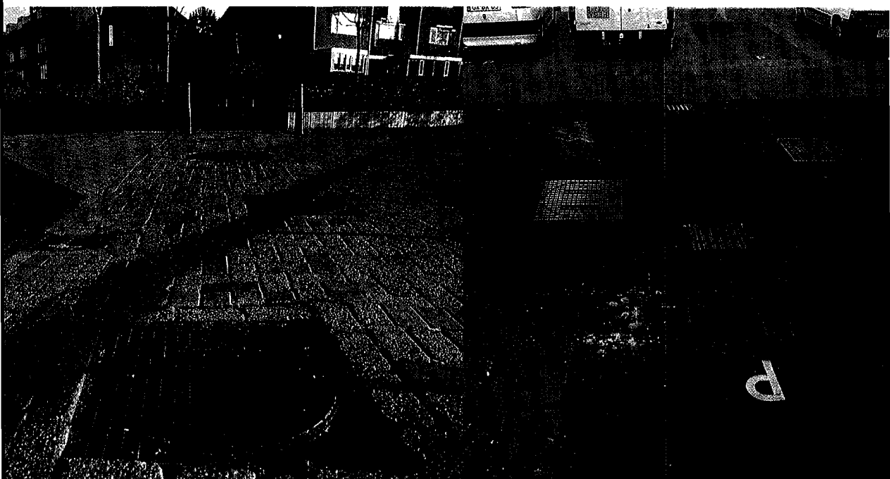
In de straten van de wijk Luchtenburg liggen veel putdeksels, ze vormen de toegang tot de pomp, slibvangput en meters.
