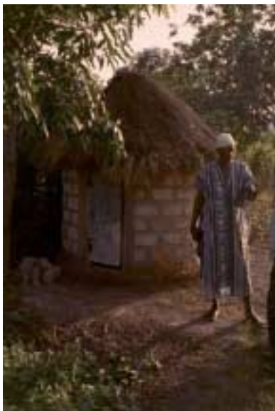
Photo 4 : Très belle superstructure en Haute Guinée
