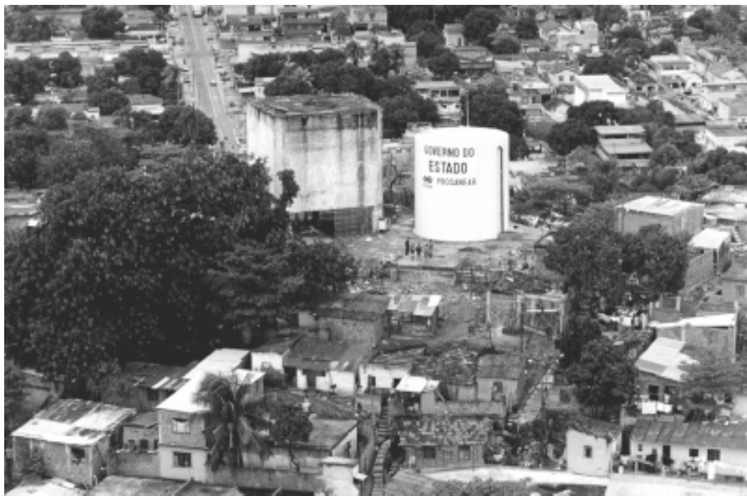
Morro União: 500 thousand liter metal reservoir
