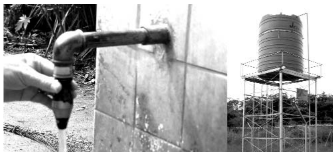
Figura 6.5c Torneira (fontanário) de um sistema accionado por energia solar
