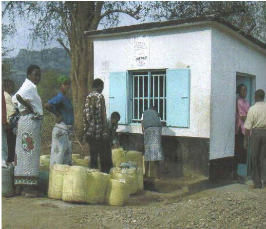
A Water Kiosk
