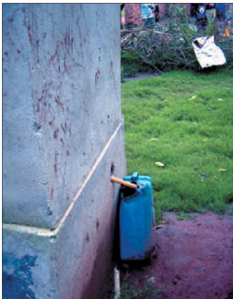
Figure 10. Dans les systèmes familiaux à petite échelle, l'urine peut être utilisée directement ou après une brève période de stockage, si les cultures sont destinées à la consommation familiale. A l'intérieur d'une famille, le risque de transmission de personne à personne est plus important qu'à travers des récoltes fertilisées par l'urine.
