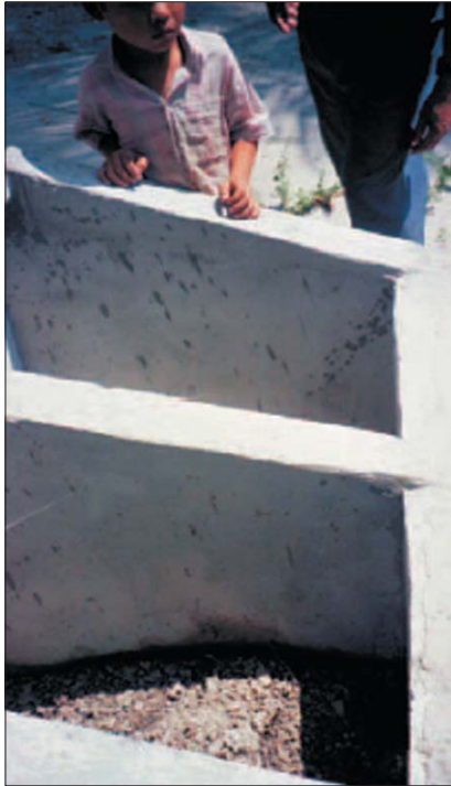
Figure 13. Il est préférable de collecter le matériau fécal dans des chambres jumelles. Une fois pleine, la chambre est scellée et le temps de stockage compte à partir de cette date, tandis qu'on se sert de l'autre chambre. Au Vietnam, où le climat est chaud, la destruction complète des œufs d' Ascaris et des virus indicateurs est obtenue en moins de six mois dans ces conditions. Si on n'utilise pas ces chambres jumelles, un stockage secondaire ou d'autres types de traitement doivent être prévus.
