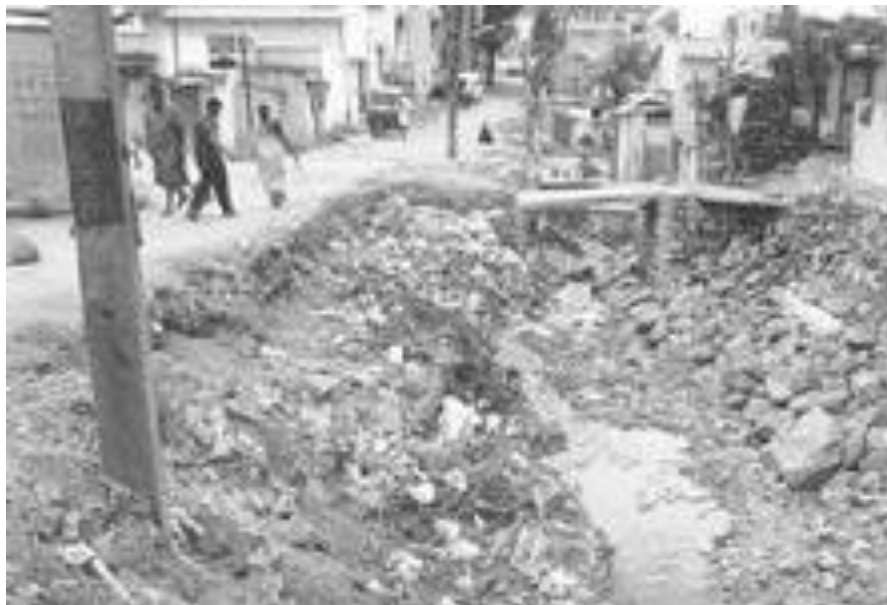
Caniveau-égout à ciel ouvert dans une ville africaine
