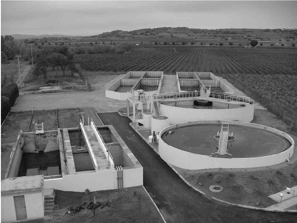
Station d'épuration dans le Sud de la France
