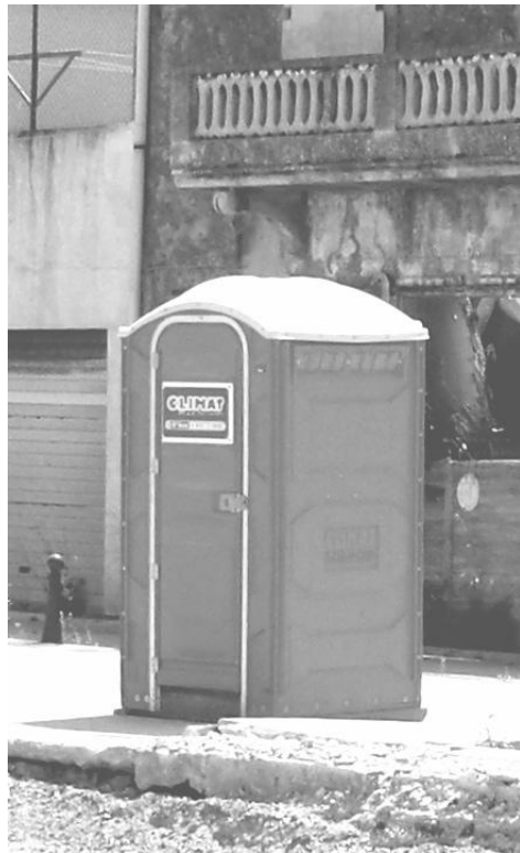
Toilettes de chantier sur le trottoir (France)
