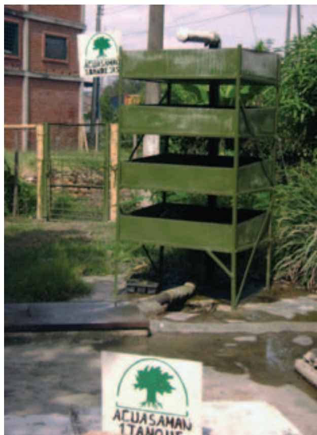
Foto 3: Tratamiento por bandejas de aireación en el acueducto de ACUASAMAN.
