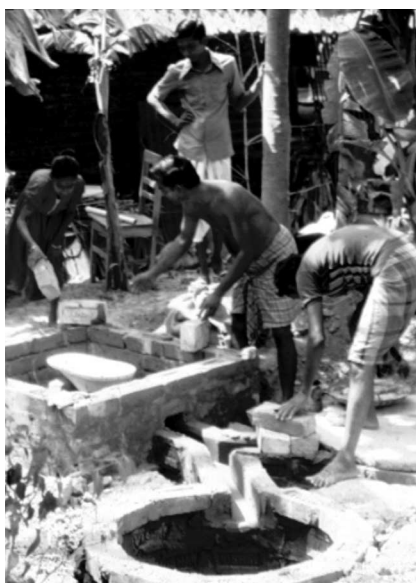
Miembros de la comunidad construyen letrinas.
