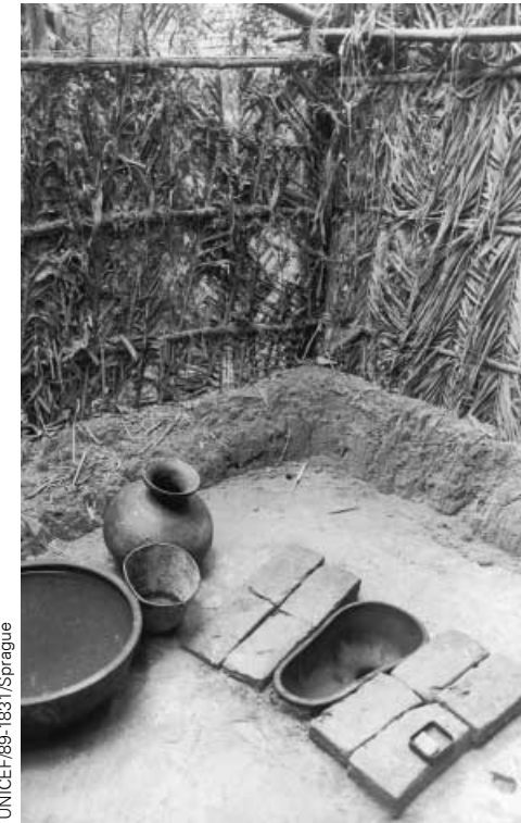
Las letrinas adecuadas pueden ser sencillas, como por ejemplo ésta, construida con material local en una zona rural de Bangladesh.
