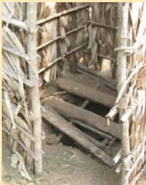
Exemple d'installation non améliorée.
